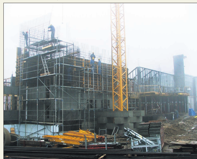
Basen rośnie w oczach, co świadczy o tym, że prace przebiegają zgodnie z harmonogramem robót. Obecnie trwają prace przygotowawcze do wykonania pokrycia dachowego.
