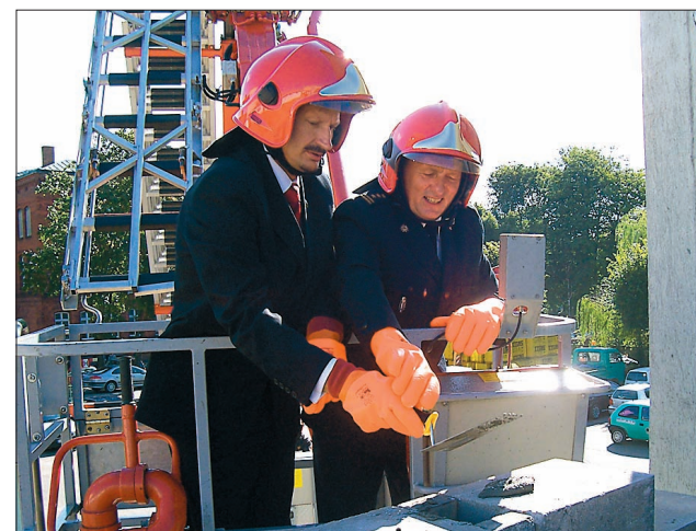
– Jedną z pierwszych decyzji starosty Wiesława Baryły (na zdj. pierwszy z prawej) było przystąpienie do budowy Powiatowego Centrum Zarządzania Kryzysowego przy Komendzie Powiatowej PSP w Kościerzynie. Na zdj. uroczystość wmurowania kamienia węgielnego pod tą inwestycję.
