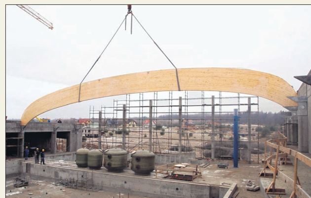
Jednymi z ostatnio wykonanych prac na basenie był montaż elementów konstrukcji dachowej – dźwigarów.
