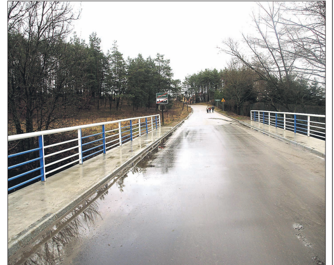
Dzięki przeprowadzonej inwestycji poprawi się komfort jazdy i bezpieczeństwo na wyremontowanym odcinku drogi. Przedsięwzięcie będzie miało także wpływ na poprawę estetyki tej często uczęszczanej przez mieszkańców i turystów drogi.
