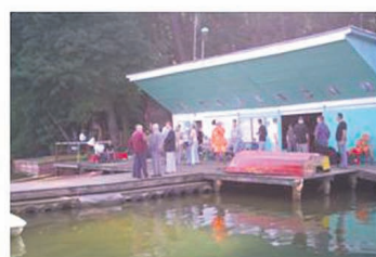
Widok przed modernizacją przystani
