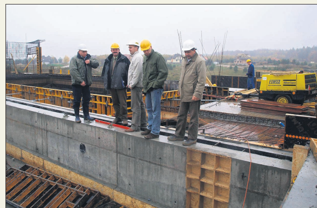
Raz w tygodniu, na terenie budowy, odbywają się spotkania zespołu monitorującego – Rady Budowy Basenu, w skład którego wchodzi wszystkie strony zaangażowane w budowę „kościerskiego basenu”.
