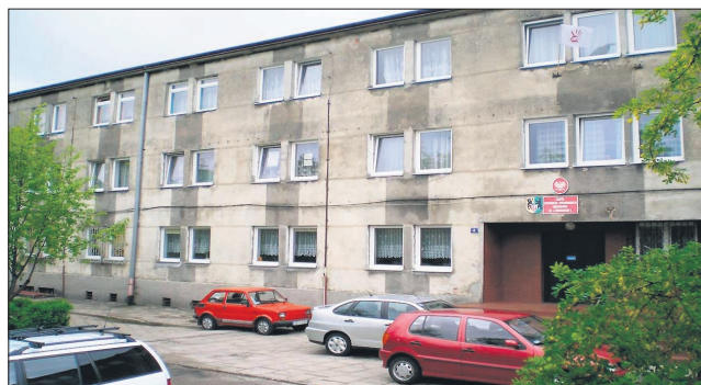
Rada Powiatu Kościerskiego przyjęła program termomodernizacji budynku, w którym mieszkają wychowankowie ZOW „Wesoła Gromadka”.
