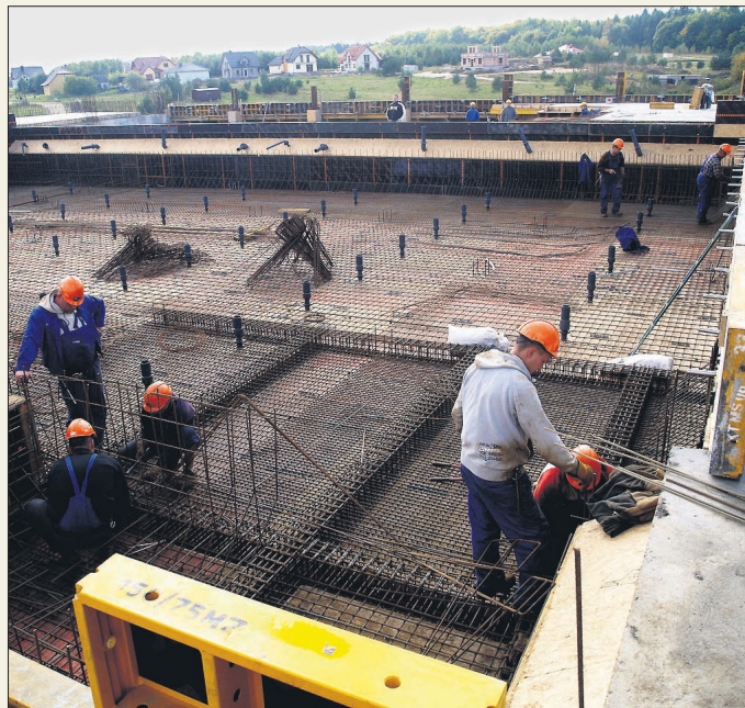
Budowa „kościerskiego basenu” przebiega zgodnie z harmonogramem. Obecnie trwa szalowanie niecki głównej basenu. Prace te są czasochłonne i wymagają niezwyklej dokładności.
